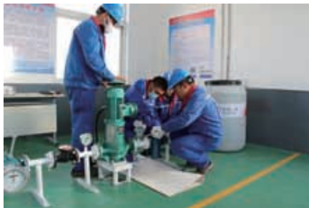
过滤器设备清洗拆卸作业
