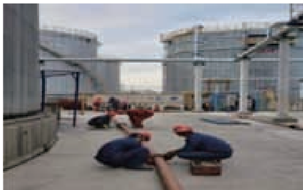
图 6 设备、管线安装
