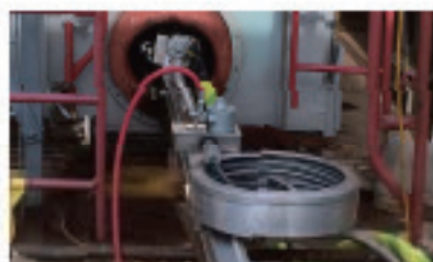
锅炉管线清洗应用
