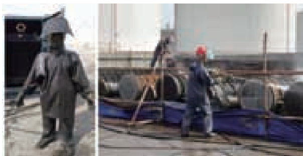
实业公司远赴抚顺石化清洗队伍清洗现场
