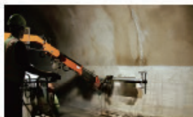
隧道清洗应用
