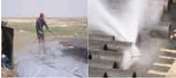
图1 油管水力自进喷头反向排垢高压破碎清洗现场
