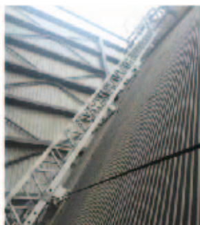
图 4 列阵排管式清洗系统
