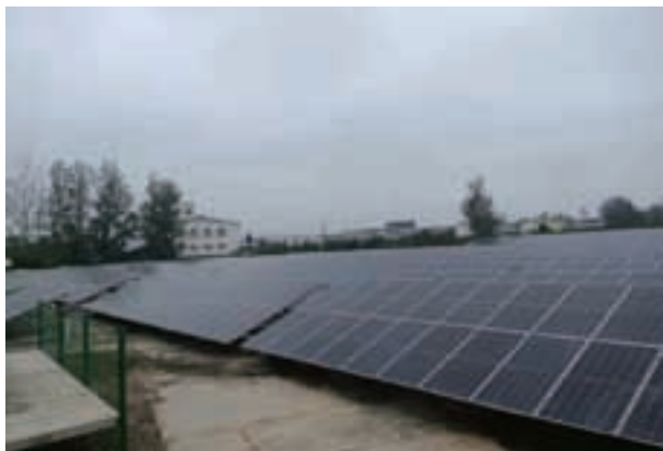
投运前检验确保项目安全运行
