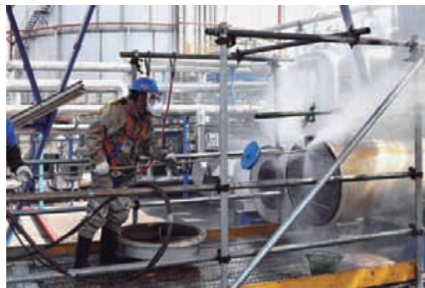
扬子石化对低温乙烯换热器进行高压射流清洗
