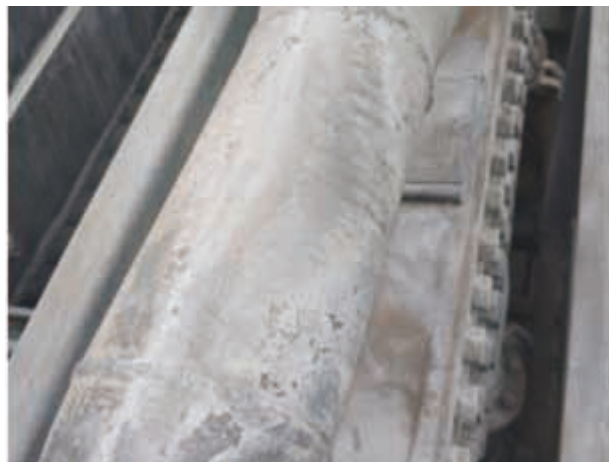
图 4 空冷器管道污垢
