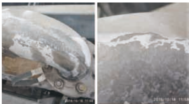
图12 空冷器管道表面污垢局部清洗现场效果
