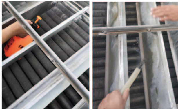
图11 空冷器清洗剂喷洒及清水冲洗
