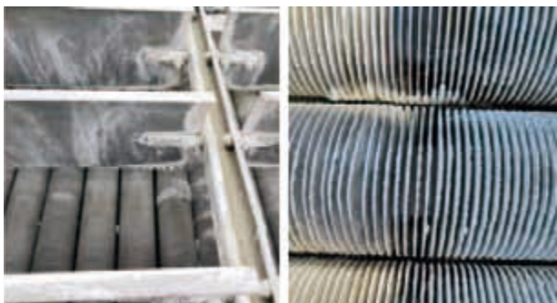
图 3 空冷器百叶窗及翅片污垢
