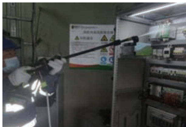
图 3 9 号风机进行电控系统、电气设备带电清洗实验工作
